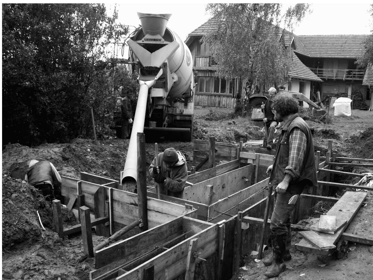
Bouw van een stukje fundering voor het verwarmingshuis op Hof Ulenkrug. In dit gedeelte van de fundering zal het „energieknooppunt“ van de boerderij ontstaan: hier komen alle warmte- en stroomleidingen samen. Op de achtergrond het nieuwe gemeenschappelijke huis, gebouwd met hout, stro en leem.
